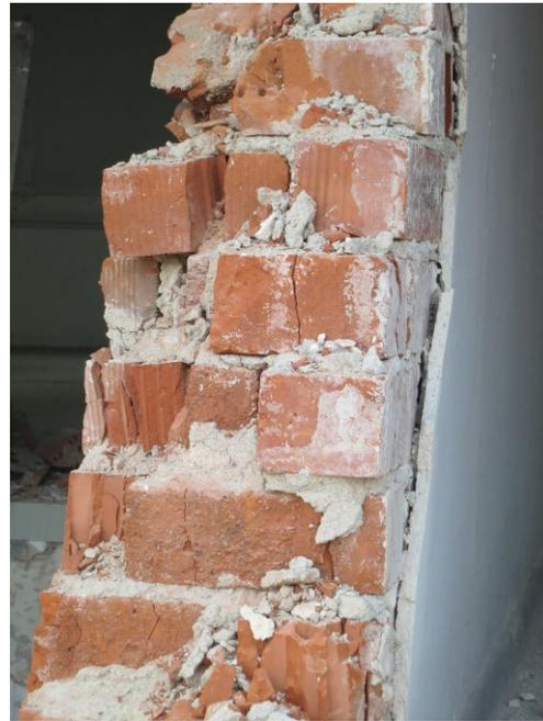
**Bild 2** Historisches Ziegelvollsteinmauerwerk. Insbesondere die Unterschiede im Zerkleinerungswiderstand beim Keramik-Gips-Verbund sind beste Voraussetzungen dafür, den Materialverbund wieder zu lösen und einen guten Aufschlussgrad mit herkömmlicher Brecher-Technik zu erzielen [6]
