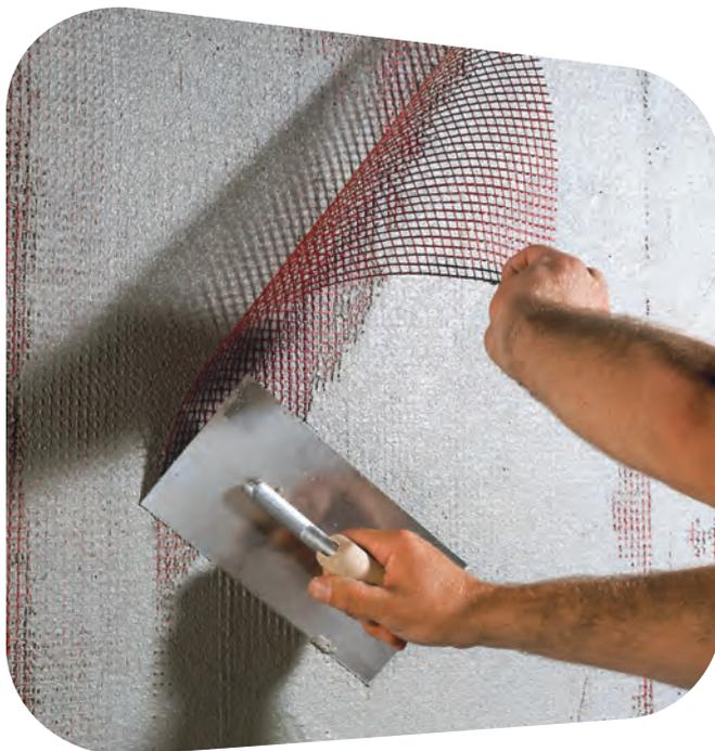
Bild 8: Armierungsputz mit Gewebeeinlage
