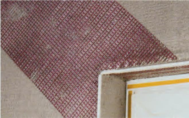
Bild 7: Armierungspfeil an Öffnungsecken
