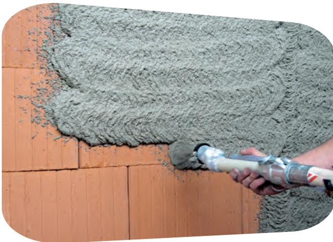
Bild 13: Auftrag des Unterputzes auf Planziegelmauerwerk
