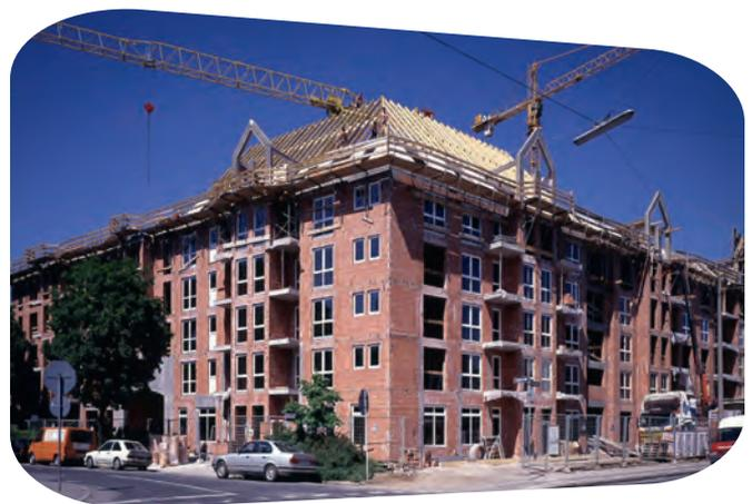
Bild 1 und 2: Homogenes Ziegelmauerwerk
