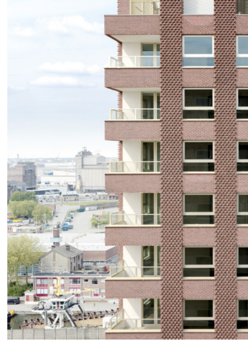
▲ Zwei Wohntürme, ein Gestaltungsmerkmal: Die vertikale und horizontale Betonung erfolgt durch vorstehende Backsteine.
