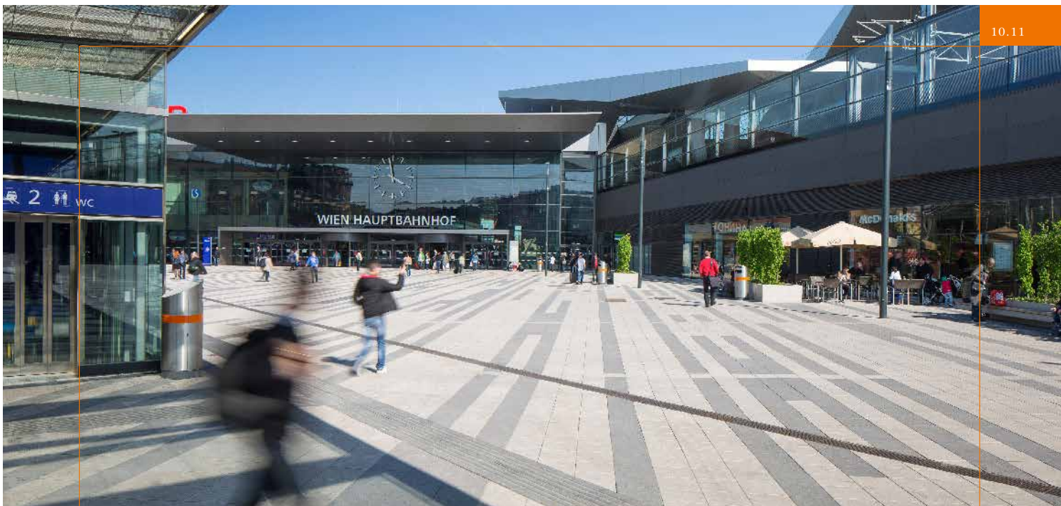
Hauptbahnhof Wien Foto: Wienerberger GmbH
