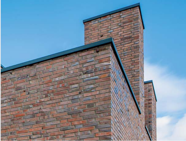
◀ Wohnhaus am Niederrhein, DE Architektur: Ferreira Verfürth Architekten, DE
