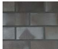
▲ Zweifaches Dünnformat
