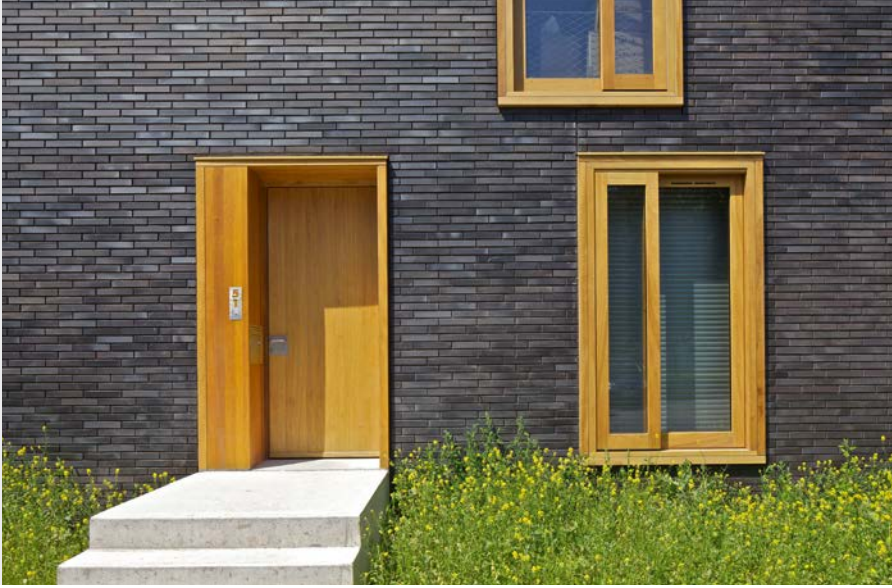
◀ 23 dwellings, FR Architektur: FRES architectes, FR mit KENK architecten, NL Fritz-Höger-Preis Special Mention Wohnungs-/Geschosswohnungsbau Fotos: © Philippe Ruault
