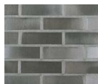
▲ Halbversetzter Läuferverband
